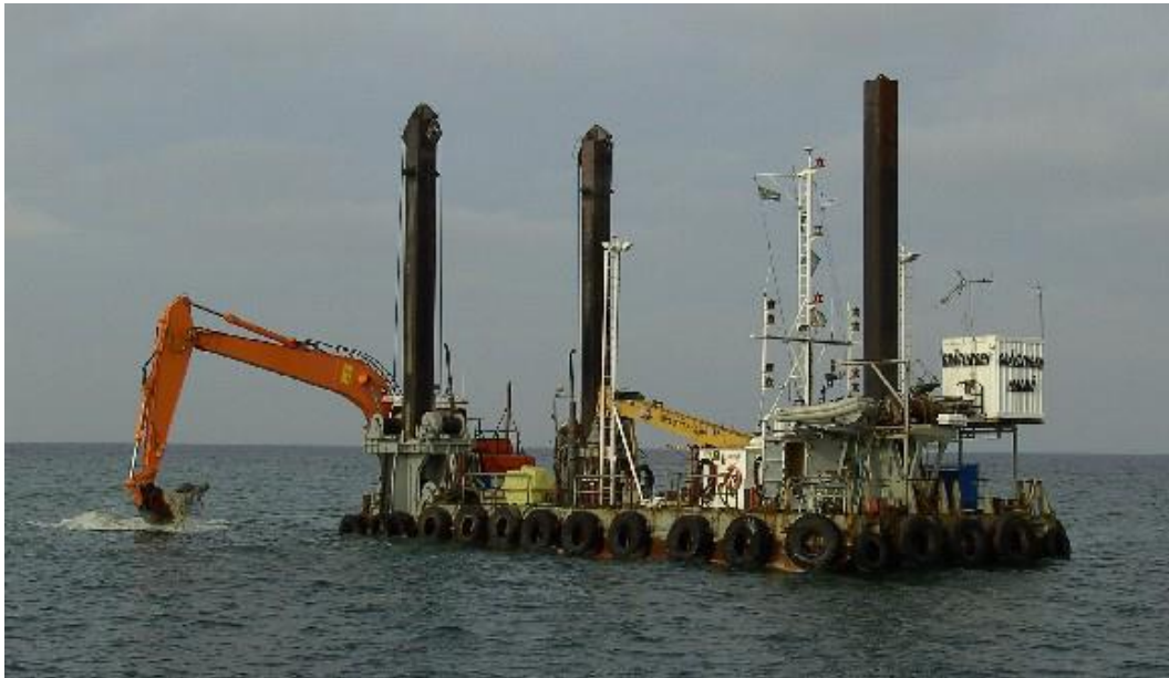
1.2.3 pav. Dugno paruošimas jūrinio kabelio klojimui (nuotrauka iš Jeppsson et al. 2008).
