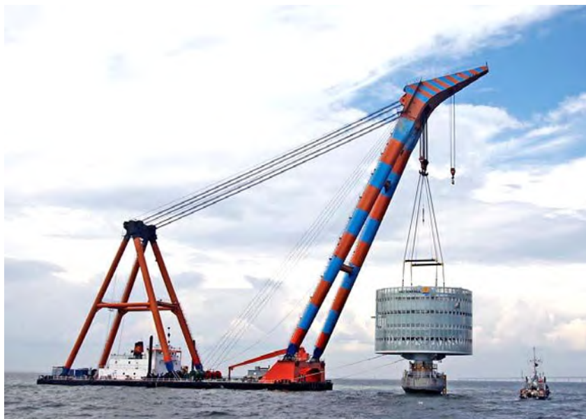
1.2.4 pav. Elektros pastotės montavimas Lillgrund VE parke (nuotrauka iš Jeppsson et al. 2008).
