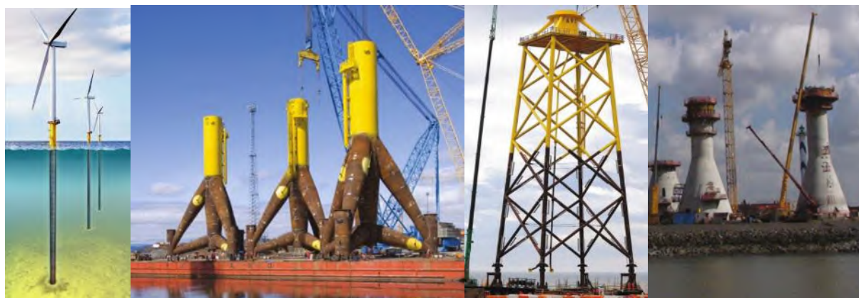
1.1.1 pav. Tradiciniai jūrinių VE pamatai: (A) monopolinis (šaltinis: Dillinger Hütte); (B) tripodas ir (C) karkasinis (šaltinis: Alpha Ventus), (D) gravitacinio pagrindo (šaltinis: Luc van Braekel).
